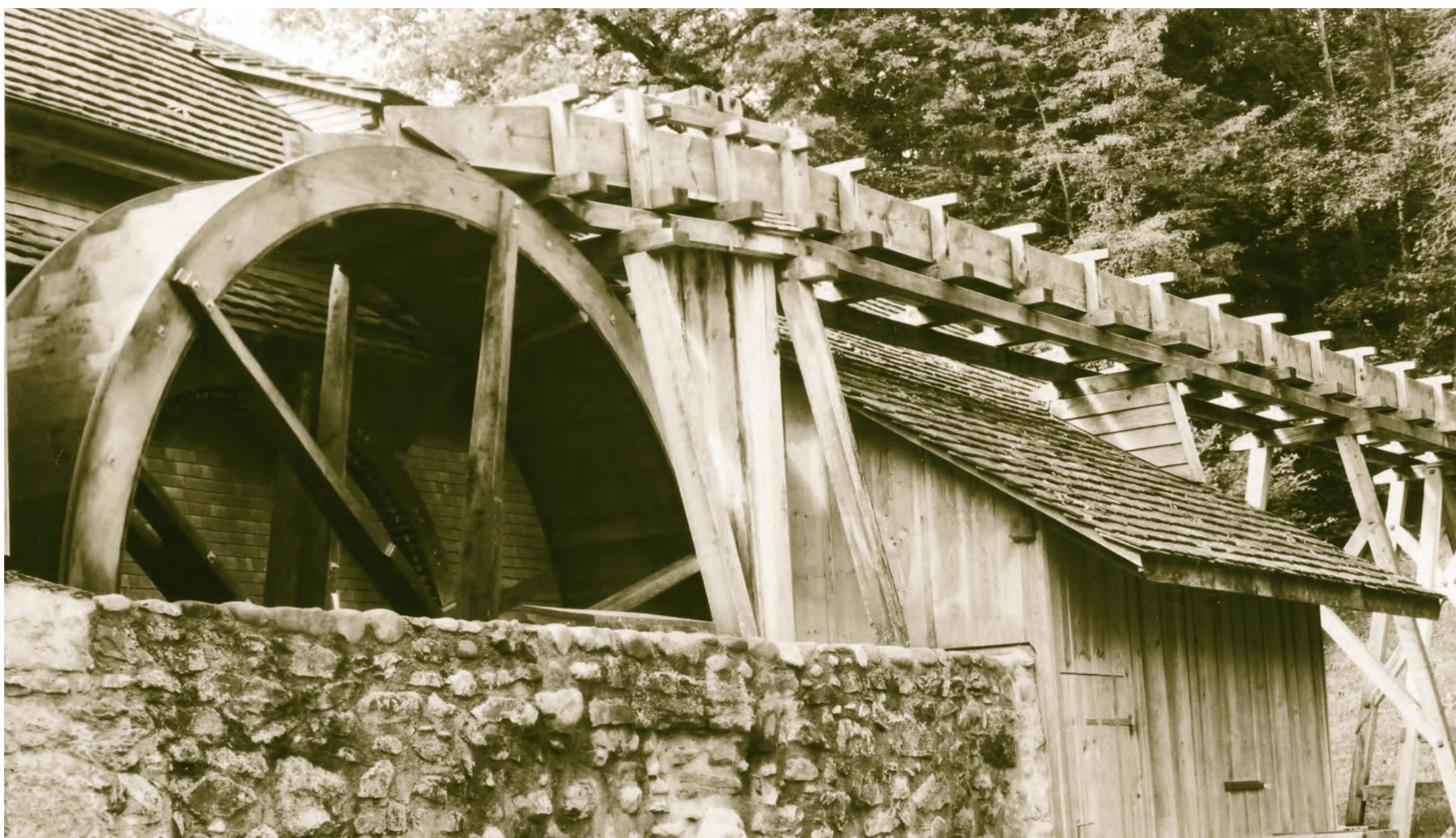
◀ Zulaufkanal und Wasserrad
