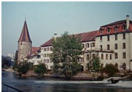
Die damalige Ansicht der Unterstadt von Bremgarten im 1974
