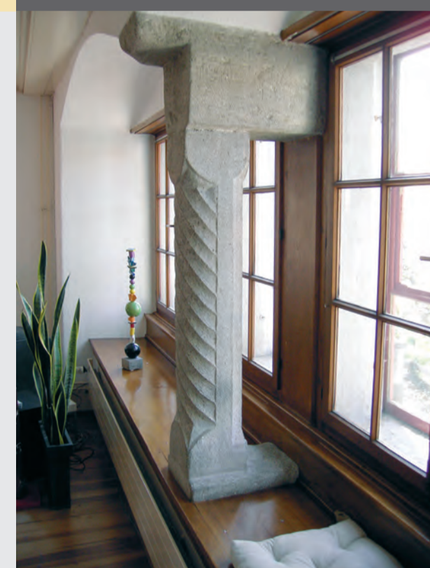
Exakt bearbeitete Säule als Tragkonstruktion in der Wohnstube im 1. Stock.
