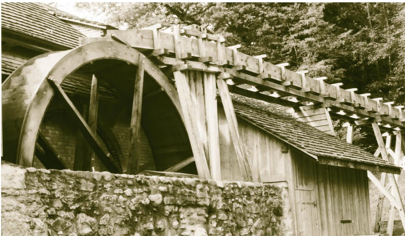
Der zum Zwecke der Restaurierung und des Weiterbetriebs gegründete Verein Wyssebacher Sagi übernimmt 1996 die baulich stark angeschlagene Sägerei im Baurecht. 1999 wird die Sägerei demontiert und fachgerecht mit teilweise neuen Elementen wieder aufgebaut. Nach der Renovation der mechanischen Teile und der Neuerstellung des Wasser- und Kammrades wird die historische Säge als Schau- und Erwerbsobjekt betrieben.
